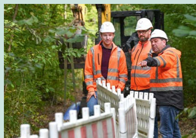
Baustellenbesprechung: Veolia betreut das Vorhaben als Betriebsführer des Wasserverbandes.
